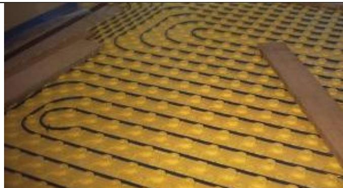
La posa in opera delle tubazioni con interassi molto ravvicinati e lo scorrimento dell'acqua a una temperatura compresa fra i 25 e i 40°C, permettono di riscaldare l'ambiente per irraggiamento (in piccola parte per convezione), mantenendo temperature del pavimento molto basse. Hanno inerzia molto elevata e generalmente si impiegano in ambienti con superfici molto ampie.
