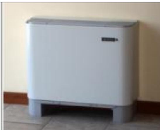
E' una specie di termosifone in cui la superficie riscaldante è molto più ampia (tubi dotati di alette). L'aria calda, per convezione sale verso l'alto. L'aria fredda scende verso il basso e viene aspirata dalla parte bassa. Sono utilizzati prevalentemente per il riscaldamento di palestre, auditori, fabbriche, ecc. Se il flusso viene creato da un ventilatore interno prendono il nome di aerotermi.
